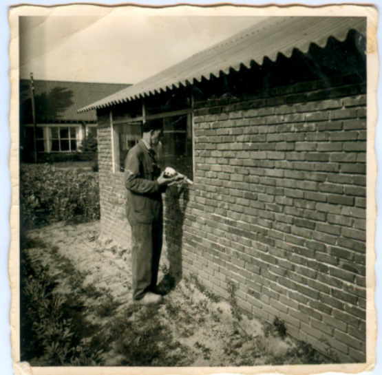
PA VERFT HET KOZIJN V.H. NIEUWE KIPPENHOK VAN HET NIEUWE HUIS 1963
