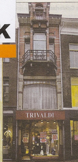
De gevel nu, nog altijd intact.
